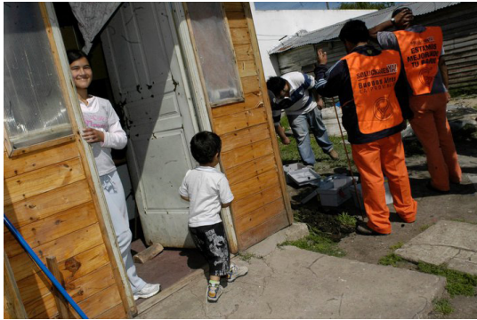
Figura 5: “Los kokitos” junto a alumnos instalando los tableros sociales. Se puede apreciar el momento en que se predisponen al hincado de la jabalina de puesta a tierra de protección.
