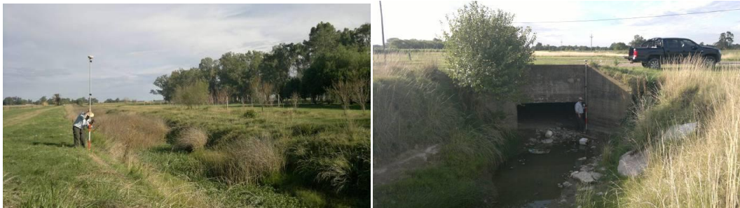
Relevamiento en el canal de descarga y alcantarillas pertenecientes.
