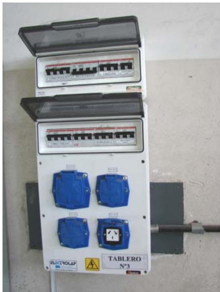
Figura 6: Vista del tablero general ubicado en el taller de Máquinas herramienta y de los tablero sectorizados por grupo de máquinas, también se puede observar en la misma la instalación del matafuego correspondiente.
