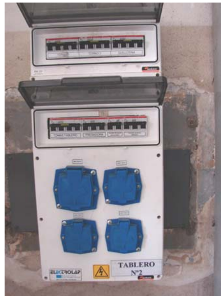
Figura 6: Vista del tablero general ubicado en el taller de Máquinas herramienta y de los tablero sectorizados por grupo de máquinas, también se puede observar en la misma la instalación del matafuego correspondiente.
