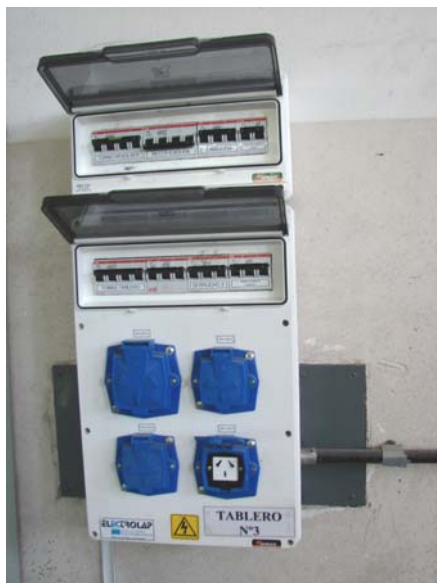
Figura 3: Vista del tablero general ubicado en el taller de Máquinas herramienta y de los tablero sectorizados por grupo de máquinas, también se puede observar en la misma la instalación del matafuego correspondiente.
