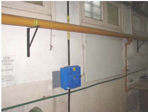
Figura 1: Nuevo tablero eléctrico e instalaciones eléctricas sobre bandejas ubicado en el taller de plasticidad del Laboratorio de Investigaciones de Metalurgia Física, con sus correspondientes llaves térmicas sectorizadas y disyuntor diferencial.
