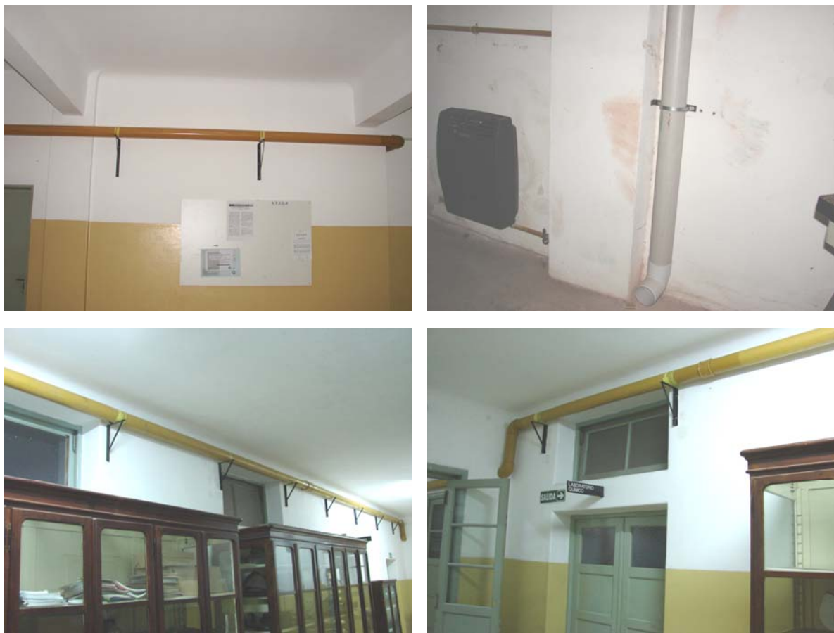
Figura 8: Vista parcial de la nueva instalación de gas en el edificio e instalación de estufas con sus correspondiente ventilación.
