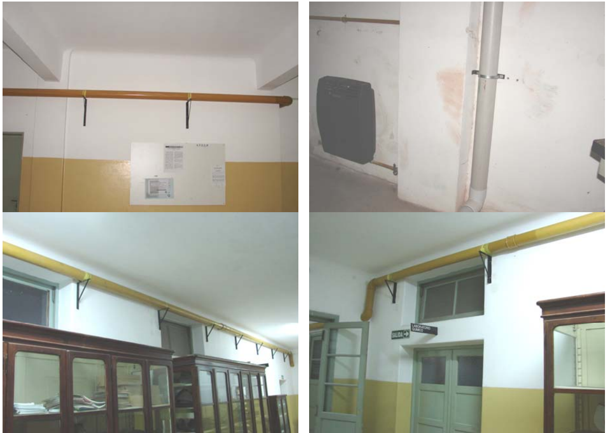
Figura 11: Vista parcial de la nueva instalación de gas en el edificio e instalación de estufas con su correspondiente ventilación.
